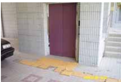
圖 4-4 破損的導盲磚
