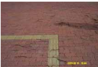
圖 4-3 未按正確方式設置之導盲磚之一
