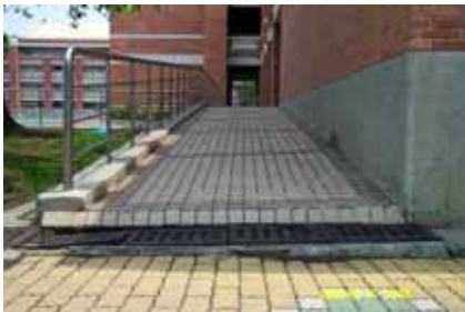
圖4-5 坡道起始處路面不平順
